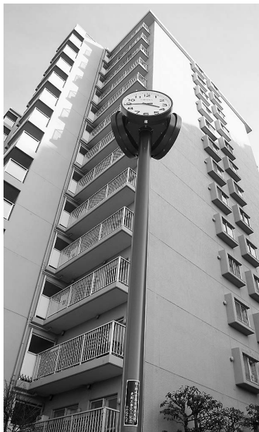
3棟15階建て・410戸全ての 専有部と共用部の給・排水管更 新工事を完了した稲毛スカイ タウンふれあいの街団地
